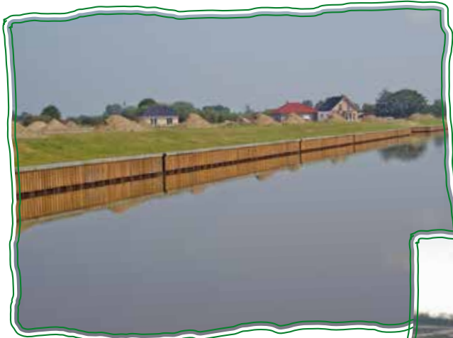
Kompl. Verkleidung und Abdeckung der Stahlpundwände am Spieksee in Rhede (Ems)
