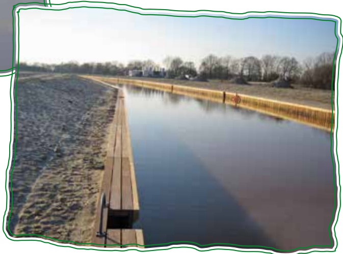
Kompl. Verkleidung und Abdeckung der Stahlpundwände am Spieksee in Rhede (Ems)
