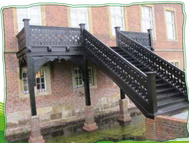
Restaurierung der historischen Treppe am Gut Altenkamp in Aschendorf
