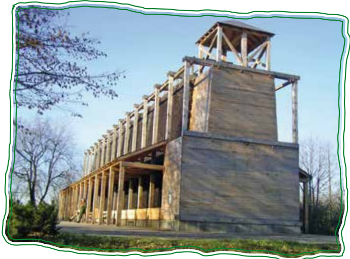
Gradierwerk Gruga Park Essen
