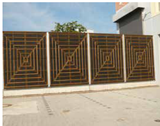
Lärmschutzwand Bad Dürkheim
